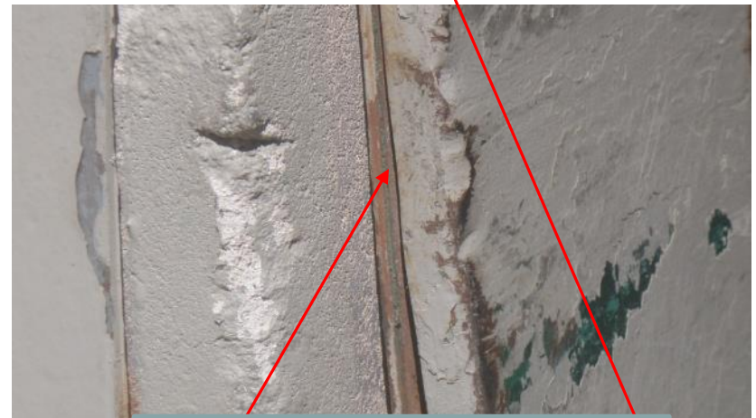
Broken door casing
